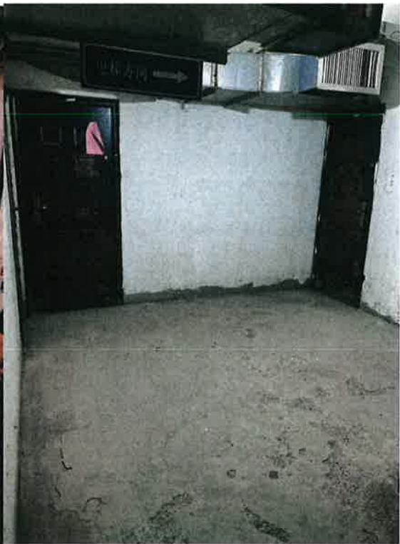
(嘉汇公司地下室)
